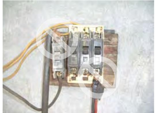
**!** 電流ブレーカーが露出して損傷した配線! このようなブレーカーは印を付けて閉鎖しておくこと。
